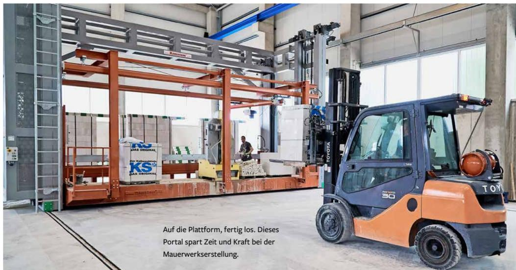
Auf die Plattform, fertig los. Dieses Portal spart Zeit und Kraft bei der Mauerwerkserstellung.
