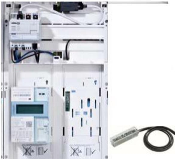
1. Der Raum für Zusatzanwendungen befindet sich innerhalb des Zählerfeldes.
