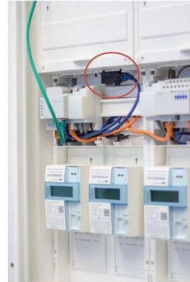
Im Zählerschrank ist ein Feld für den Einbau der Kommunikationseinrichtung und dem Anschluss an die ITK (Anschlusspunkt Leitung, APL) vorgesehen. Das Feld ist anschließend mit einer Plombe zu sichern
