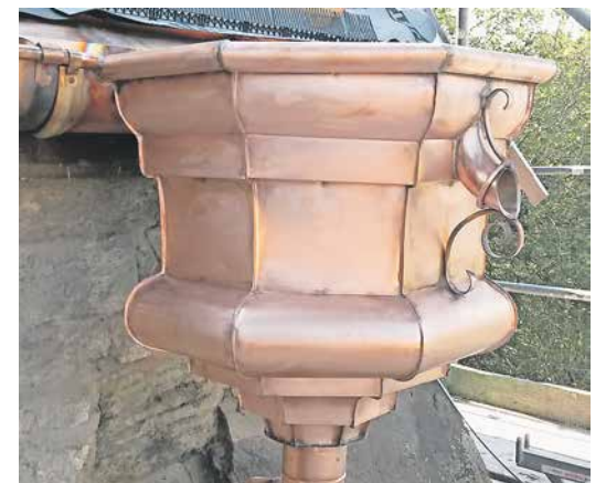
Auch ein Werk von Dachdecker Weiß: Vier dieser handgefertigten Kupferkessel zieren die St. Marienkirche.
