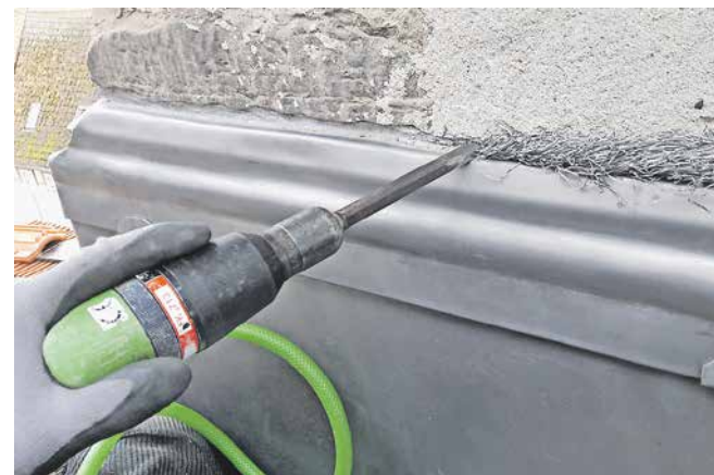
Aufwendig aber ewig haltbar: Die Anschlussfuge dichtet Marco Weiß mit Bleiwolle ab. Wichtigstes Hilfsmittel dabei ist sein Drucklufthammer.
