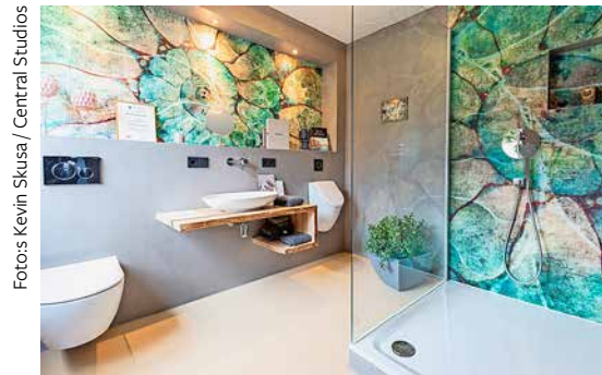
Im Ausstellungsbad hat der Meister eine wasserdichte Designtapete verklebt, die in Türkistönen schillert.
